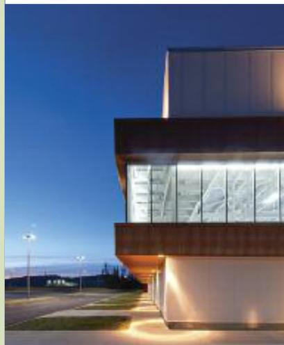
**PREPAINED GALVANIZED WALL CLADDING**
