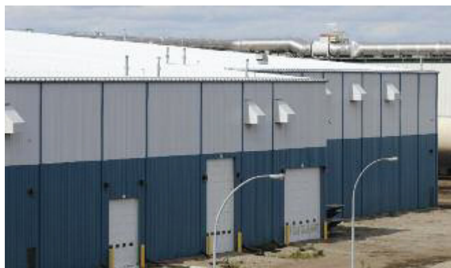
Le toit à joint debout de ce bâtiment est revêtu de 19 417 m 2 (209 000 pi 2 ) de Galvalume AZM165 Plus non peint de 61 mm (0,0239 po) d'épaisseur et d'un revêtement en acrylique.
