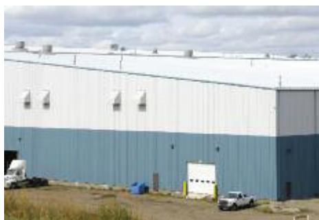
Le toit à joint debout de ce bâtiment est revêtu de 19 417 m 2 (209 000 pi 2 ) de Galvalume AZM165 Plus non peint de 61 mm (0,0239 po) d'épaisseur et d'un revêtement en acrylique.
