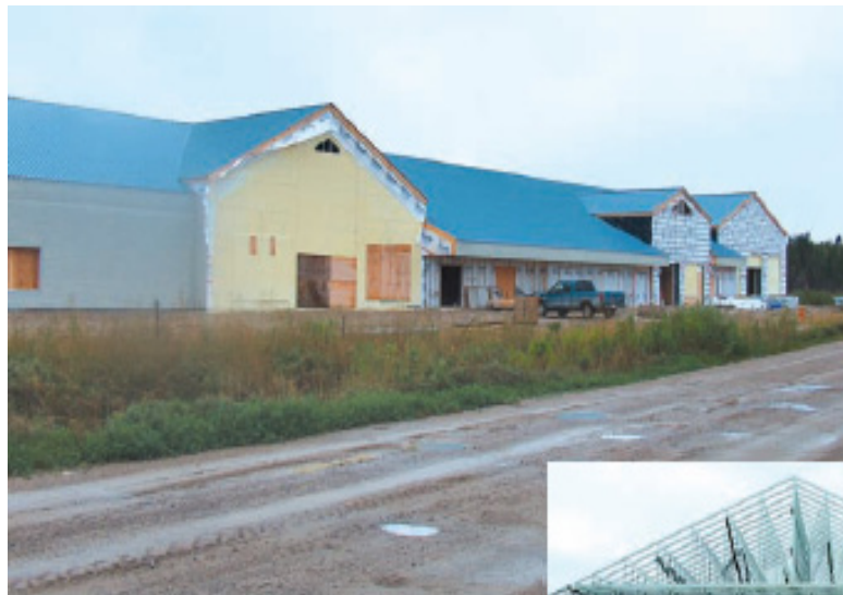
La charpente métallique légère a été utilisée pour les murs porteurs, les murs en contrevent, les poteaux de toiture en acier, les poteaux de plancher en acier au niveau de la mezzanine, un platelage en acier avec béton, un revêtement à la mezzanine et une toiture en acier préfinie.
