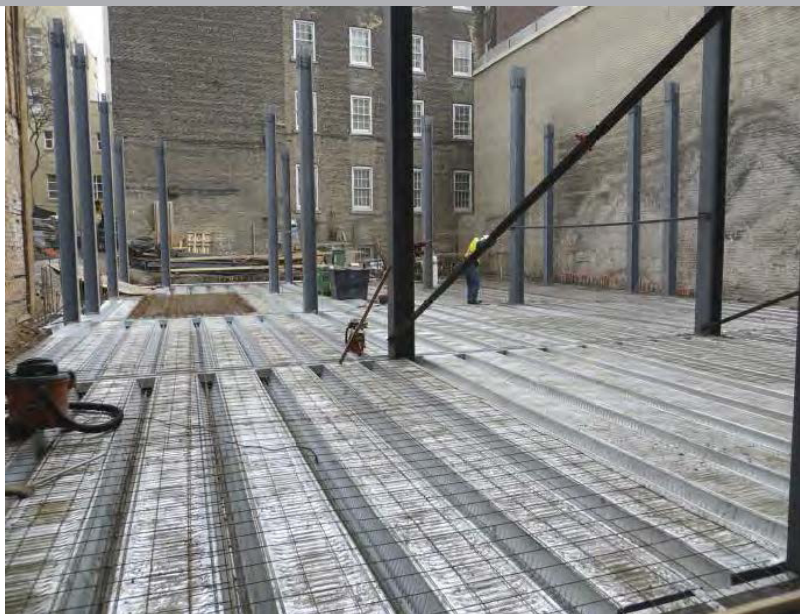
ComSlab au rez-de-chaussée, prêt pour couler le béton.
