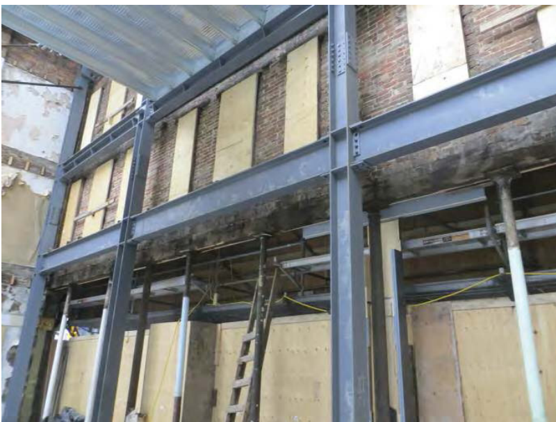
ComSlab au rez-de-chaussée, prêt pour couler le béton.
