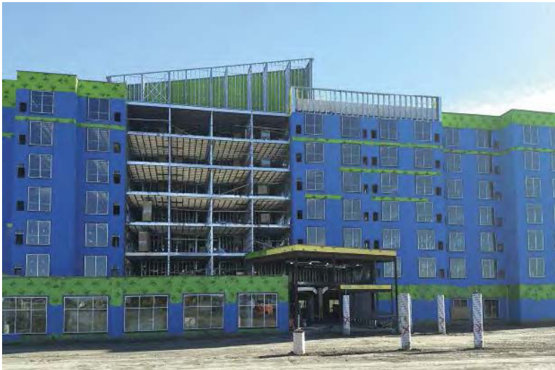
Le bâtiment de sept étages est constitué de colonnes en acier de construction et d'une charpente en acier usiné à froid (AUF). Ce système est léger et non combustible, qui s'installe rapidement et procure un rendement plus rapide du capital investi.
