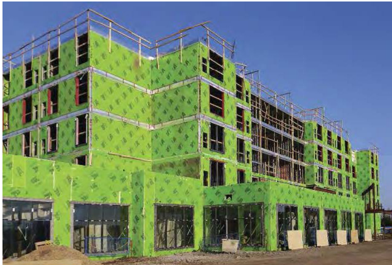
Les assemblages de murs en acier usiné à froid sont légers, robustes, résistants au feu et faciles à utiliser, en plus de permettre d'achever la structure plus rapidement.
