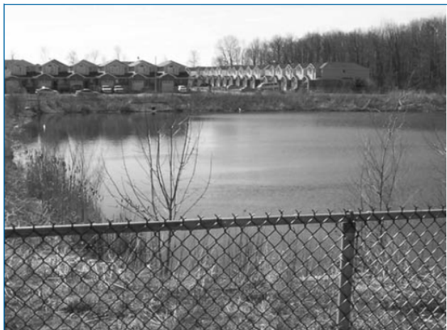
Figure 4 : Étang de gestion des eaux pluviales
