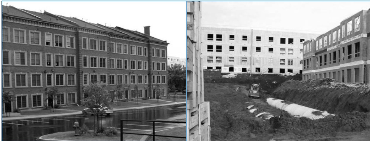
Figure 5 : Les systèmes de rétention à buses en tôle ondulée sont discrets et dimensionnés conformément aux exigences du site
