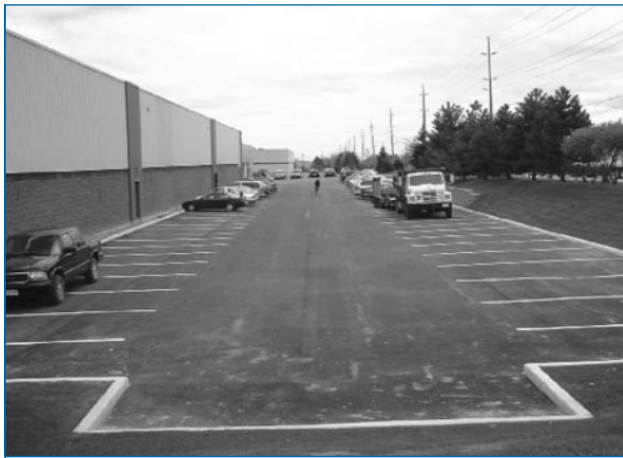
Figure 3 : Les parcs de stationnement sont parfois idéaux pour contrôler les eaux pluviales
