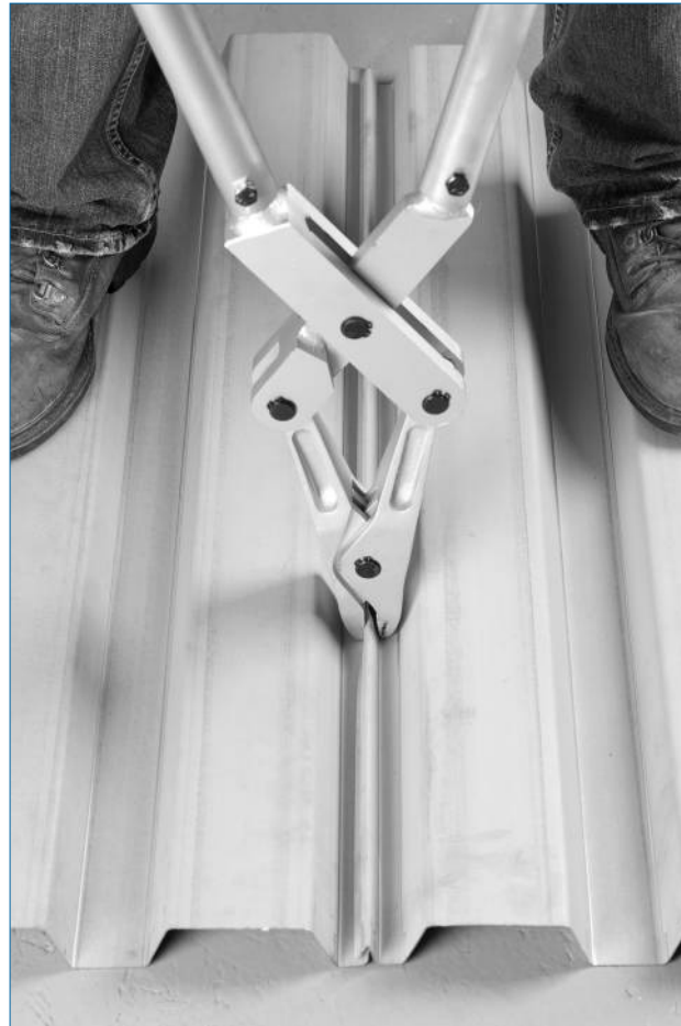
Figure 2: Connexion poinçonnée (sertissage manuel)
