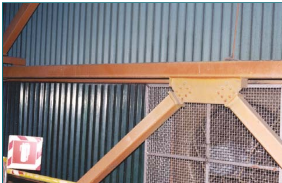
Figure 3: Intérieur d'une affinerie minière. Le revêtement Barrière est situé au-dessus de l'aspirateur. Dix-neuf ans d'exposition dans le nord de l'Ontario.
