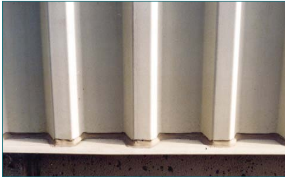
Figure 9: Exemple d'une rive bien calfeutrée sur un mur extérieur.
