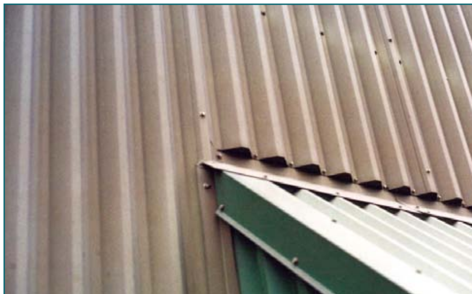
Figure 2: Extérieur d'une fonderie minière. Bord inférieur et revêtement incliné à 45°. Dix-neuf ans d'exposition dans le nord de l'Ontario.
