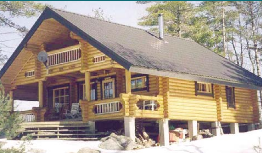
Figure 8: Chalet en Ontario, couverture de type Barrière 100/feuille protecteur. Cinq ans d'exposition.
