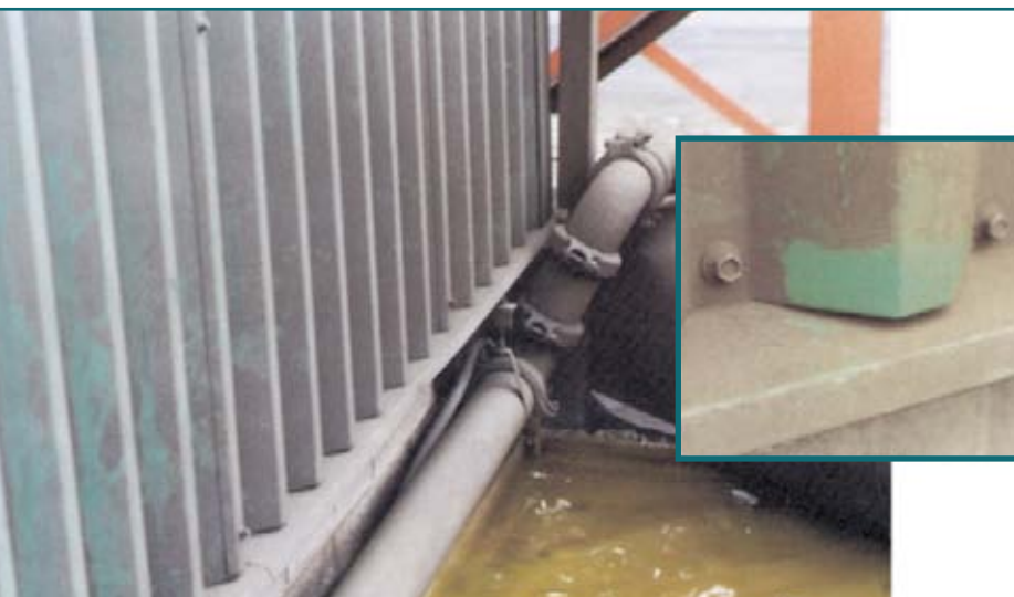
Figure 1: Tour de réfrigération d'eau d'un site minier. Orientation ouest au-dessus des réservoirs. Photo insérée: Un nettoyage rapide a démontré l'excellente condition du bord d'égouttement. Onze ans d'exposition dans le nord de l'Ontario.
