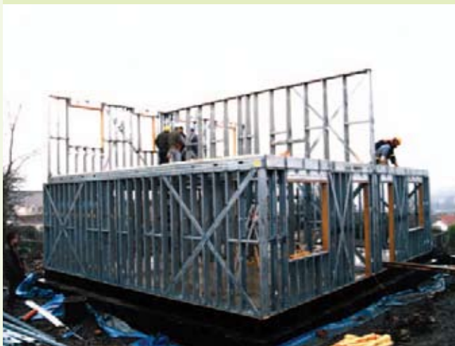
Figure 3 · Construction typique à ossature d'acier léger
