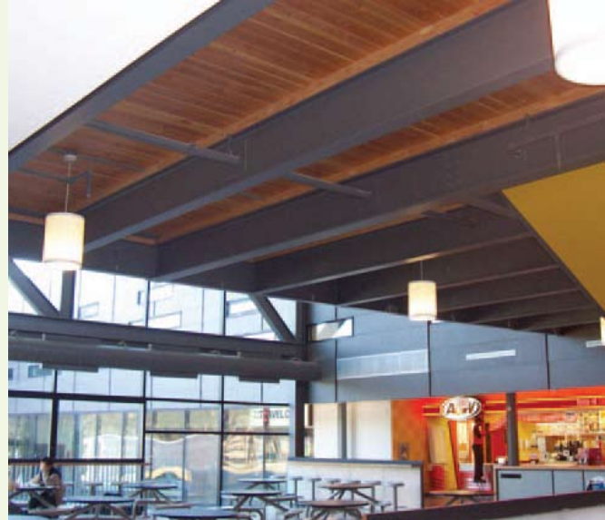
Figure 3 · Le centre des étudiants du Campus de Scarborough de l'Université de Toronto intègre de l'acier récupéré.
